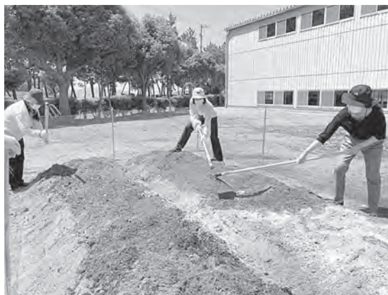
図2 石灰と真砂土を混ぜる様子
